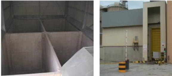
2012: DIB1 : plateforme de préparation Mix pneus broyés + bois + RBA
