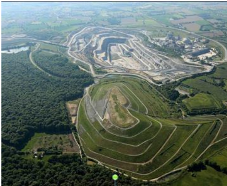
Merlon de la prise Goberon (achevé)
